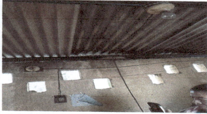
Foto 7: Reparación del sistema eléctrico.
