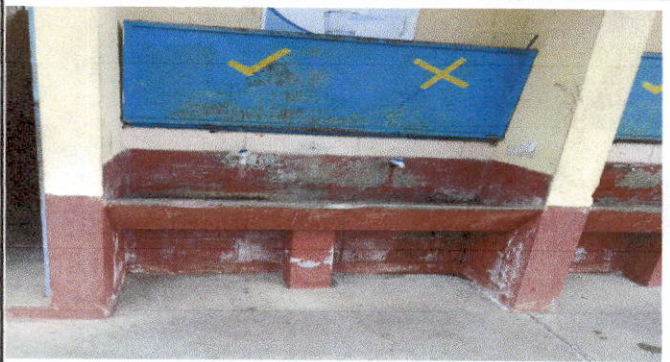
foto 16: Sustitución de azulejo.
