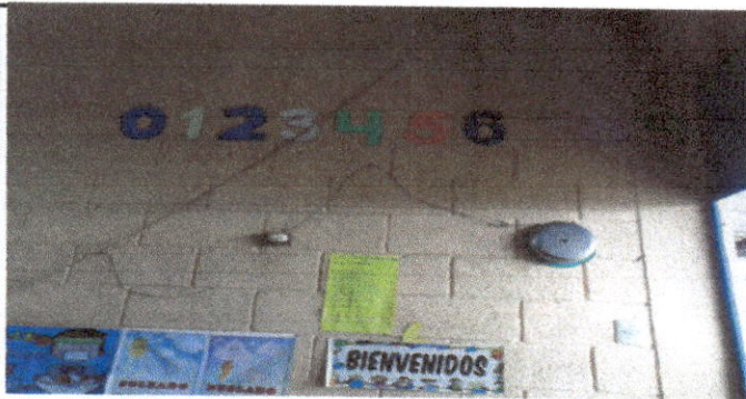
Foto 11: Reparación del sistema eléctrico más accesorios.
