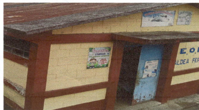
Foto 3: Puertas. Mantenimiento a estructura (lijado, cepillado, aplicación de pintura).
