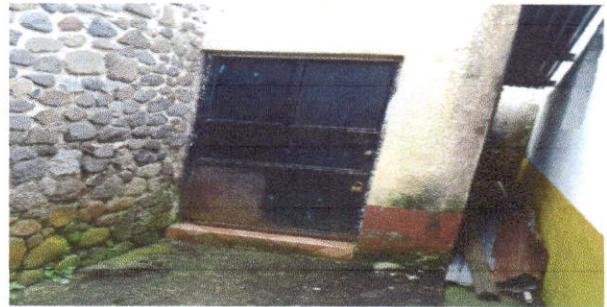
Foto 4. Fabricación e instalación de puerta de metal en módulos.
