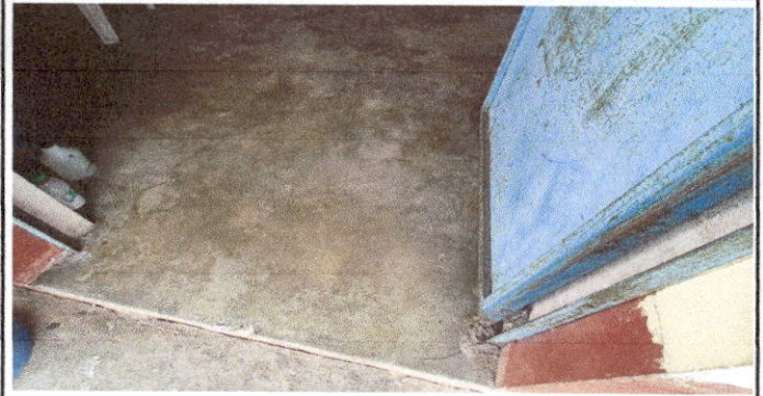
Foto 14: Sustitución de piso de cemento liquido (por piso cerámico).
