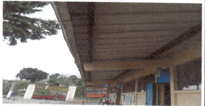
Foto 10: Sustitución de canales y bajadas de agua pluvial.
