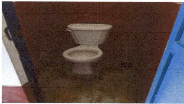
Foto 15: Sustitución de accesorios inodoro.
