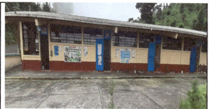
Foto 18. Pintura en muros interiores y exteriores.
