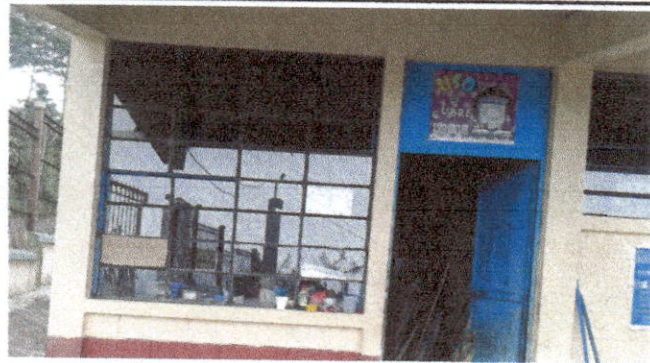
Foto 9: Mantenimiento a estructura de metal de ventana.
