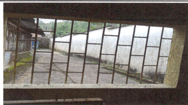
Foto 5: Sustitución de ventana de metal por ventana de pvc.
