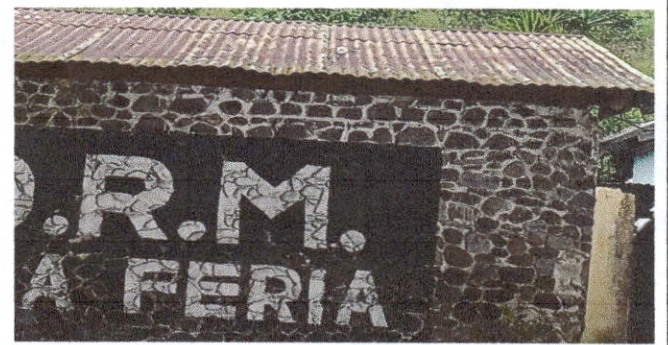
Foto 6: Sustitución de canales y bajadas de agua pluvial de pvc.
